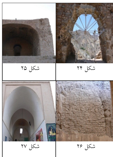
شکل ۲۴ تا ۲۷. نحوه ایجاد تاق گهواره‌ای در بنای خانه دیو سبزواری (شکل ۲۴)، بنای سنگی اسپاخو (شکل ۲۵)، مسجد کوشک فردوس (شکل ۲۶) و مسجد رقه (شکل ۲۷) (مأخذ: نگارندگان)
